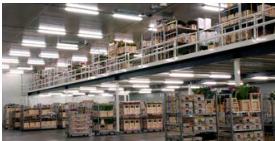
Med Mezzanin ME300 udnyttes lokalets højde til at skabe yderligere lagerkapacitet. Her vises en installation fra en blomstergrossist.
